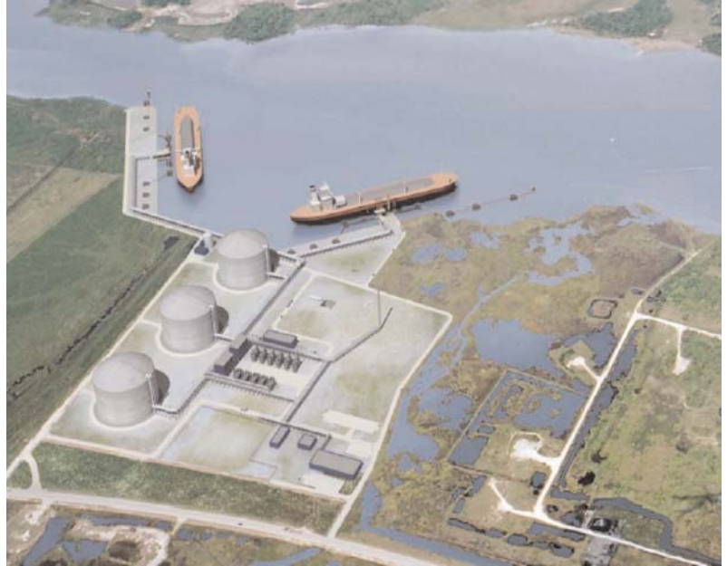
Proposed Cameron LNG Terminal.
